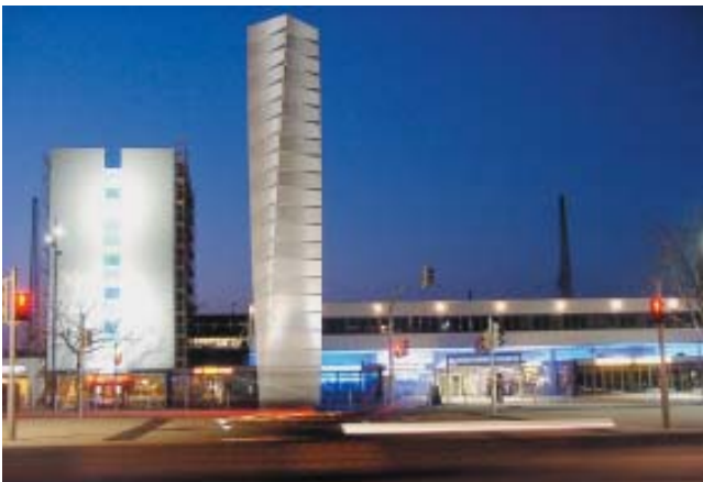
Bahnhof in Kehl nach der Revitalisierung
